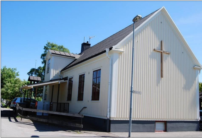
Ansicht von Westen, alter Kapellbau (1930)
